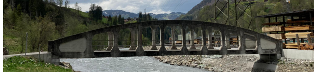
Figure 1: Le Pont de Dalvazza
