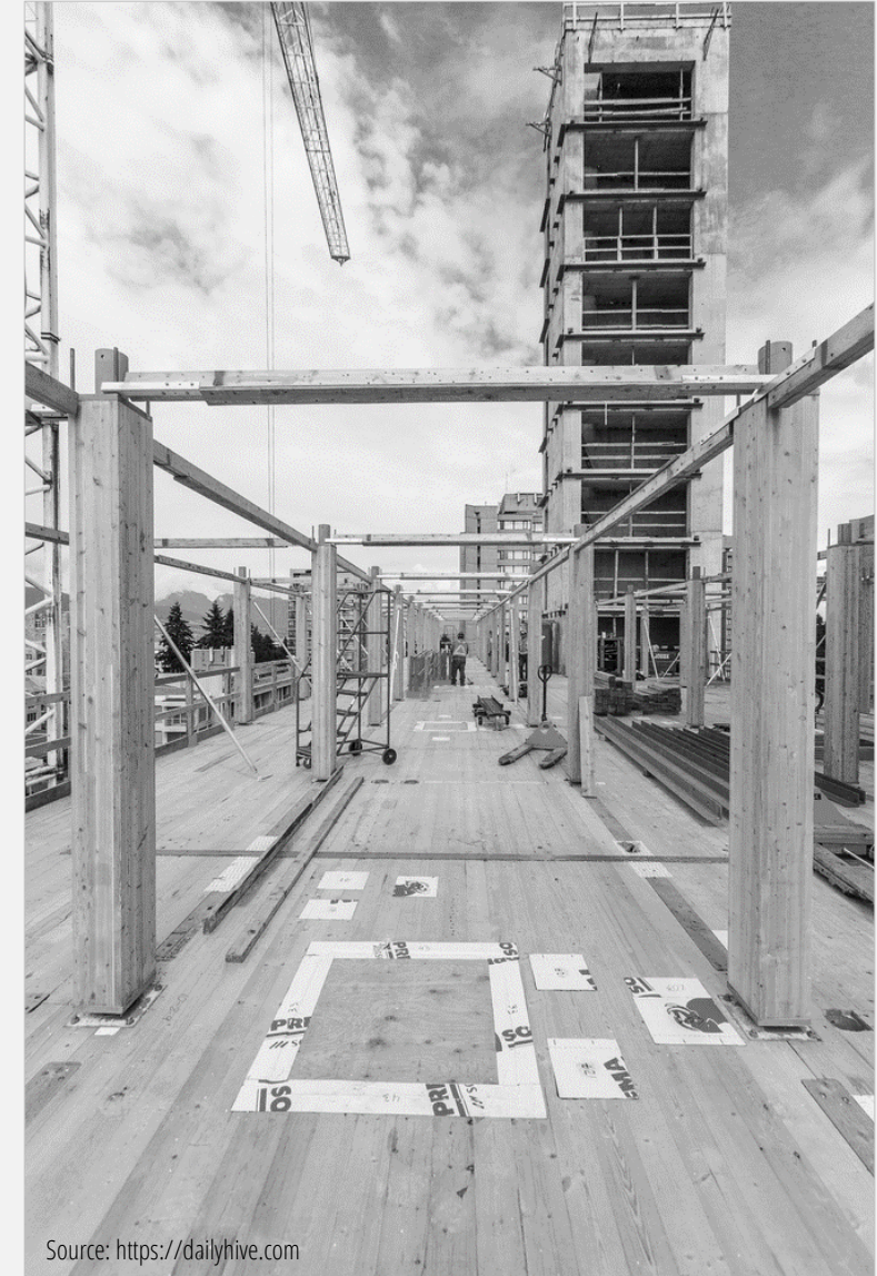
UBC TallWood House · Brock Commons · Vancouver, CA · Fast + Epp · 2019
